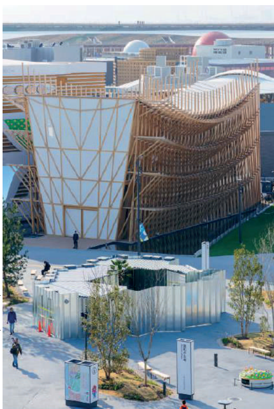
Pavillon du Bahreïn, Osaka Expo 2025, Osaka, Japon Assemblé à partir de 3 000 pièces de bois brut et de menuiseries d'exception, cet ouvrage, sans béton ni déchet, célèbre l'artisanat et la réversibilité des matériaux.
